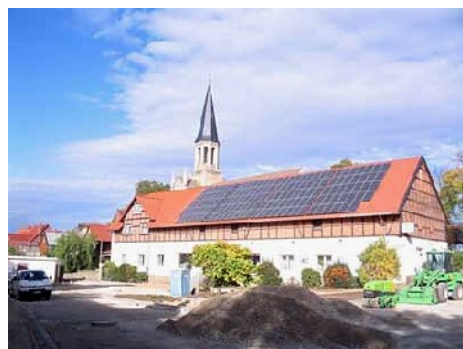
Moduły fotowoltaiczne na dachu w Dardesheim w Niemczech.
